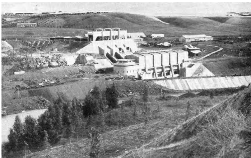
Hydroelektrownia zbudowana u zbiegu Jordanu i Jarkonu
