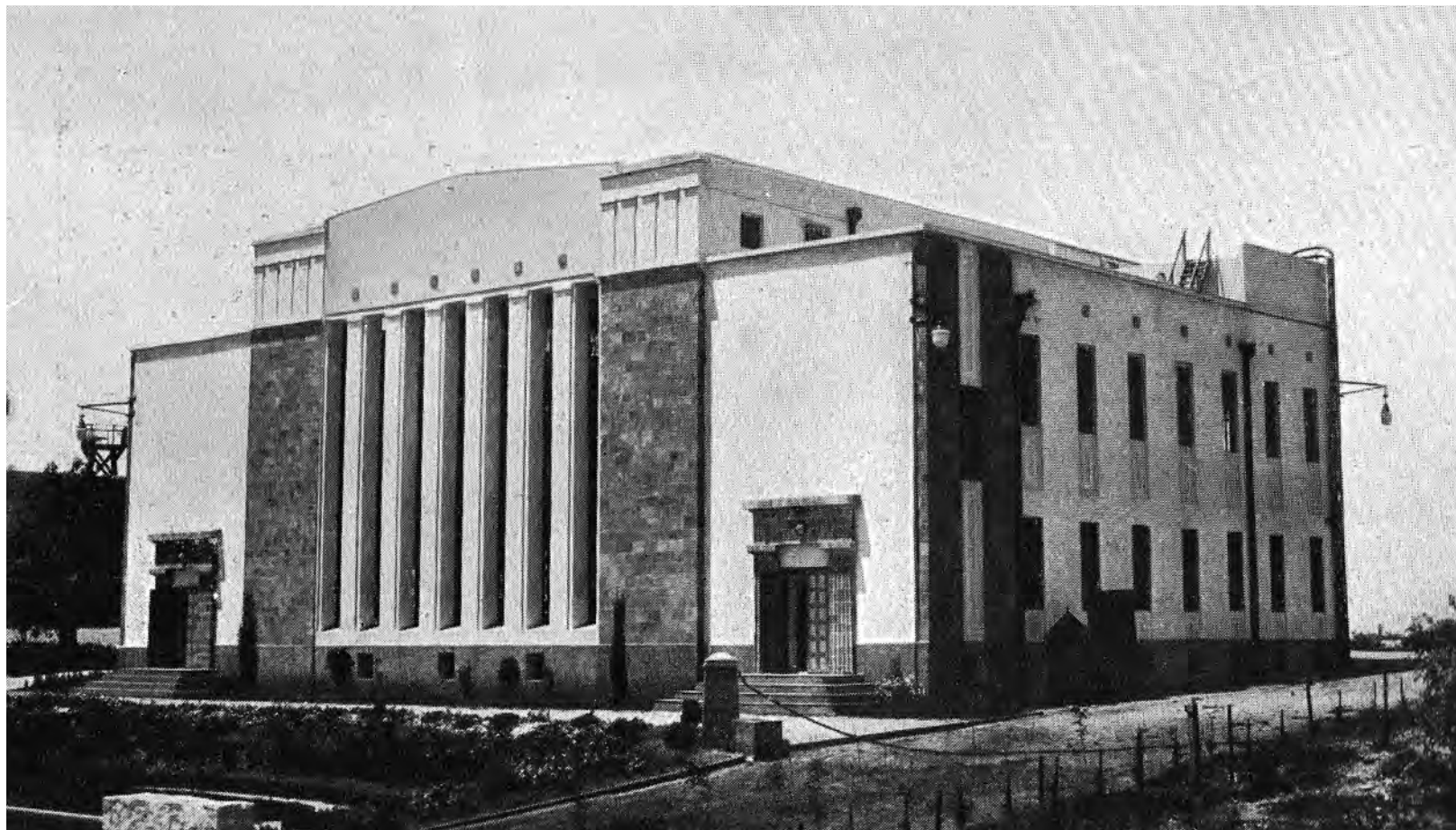
Budynek Palestyńskiej Korporacji Elektrycznej założonej przez Rutenberga
